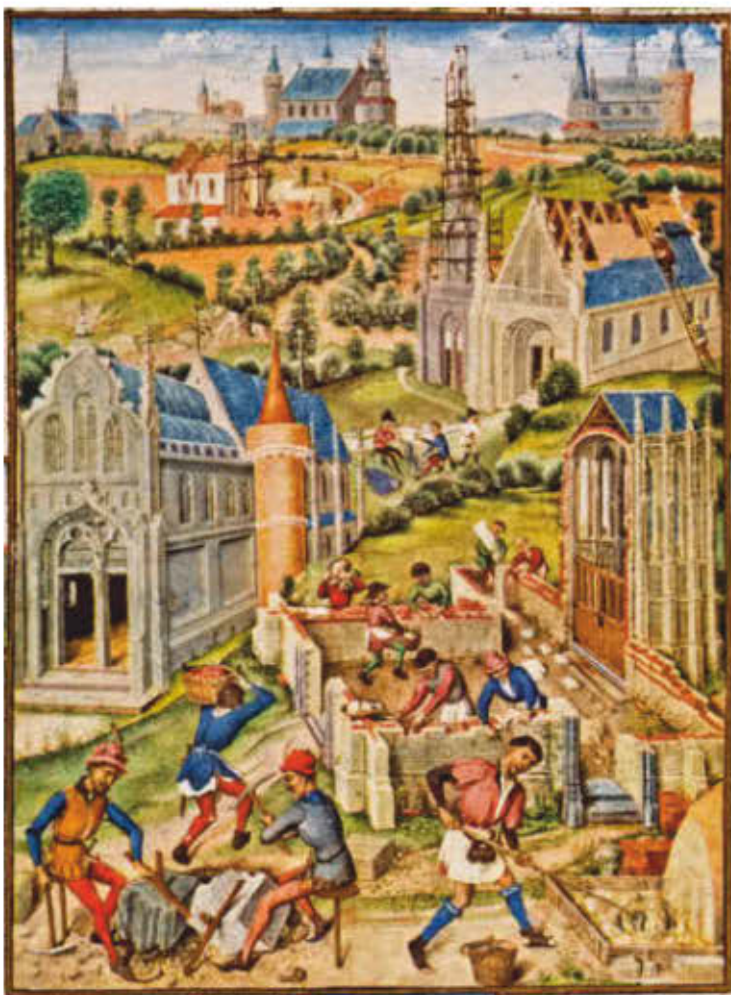
▲ Construction d'églises abbatiales et cathédrales.
